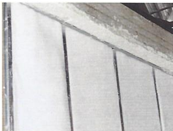
Foto 1 – Detalhe da montagem
