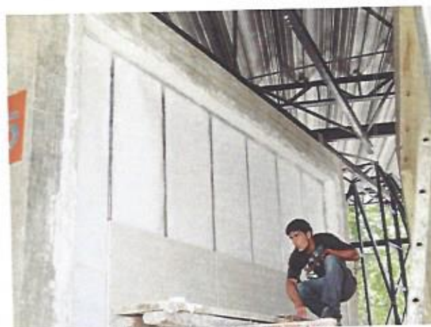
Foto 2 – Instalação da lâ
