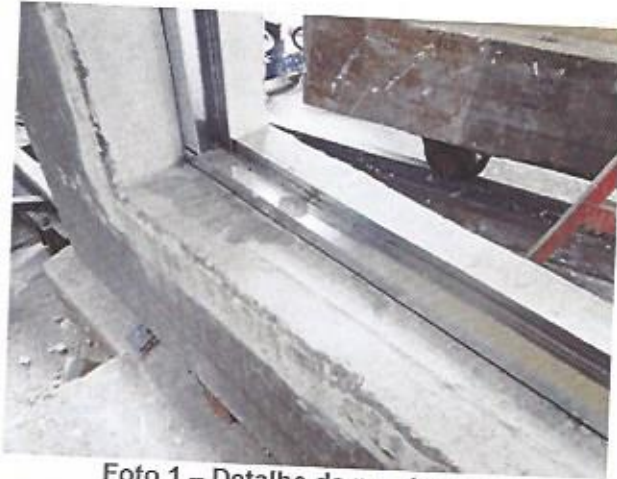
Foto 1 – Detalhe da montagem
