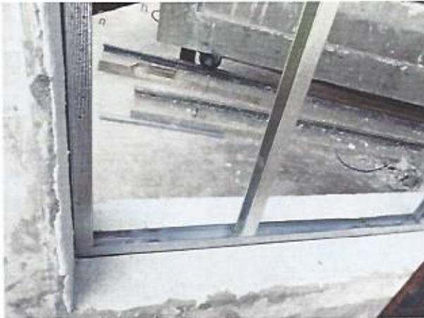
Foto 1 – Detalhe da montagem
