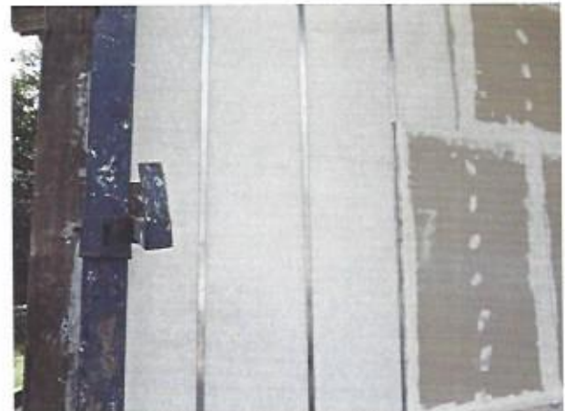
Foto 2 – Instalação da lâ
