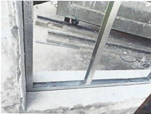
Foto 1 – Detalhe da montagem
