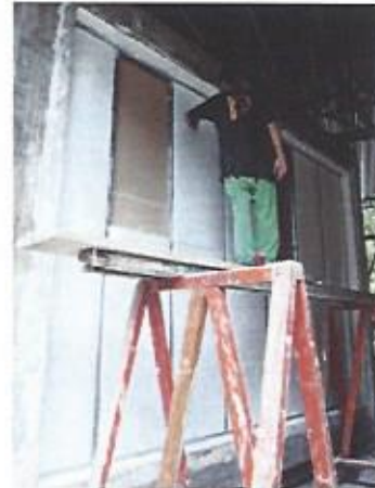
Foto 2 – Instalação da lâ
